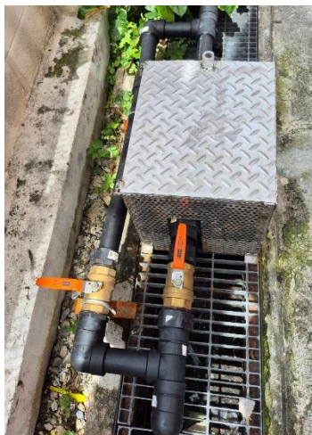
รูปที่ 25 โพลทวาล์ว ควบคุมระดับน้ำ
