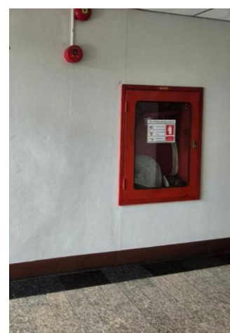
รูปที่ 17 ตู้เก็บสายฉีดน้ำดับเพลิง
