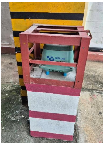
รูปที่ 1 เครื่องเติมอากาศลงบ่อเกรอะ
