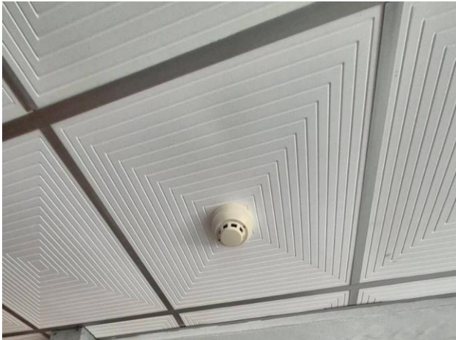
รูปที่ 13 เครื่องตรวจจับความร้อน
