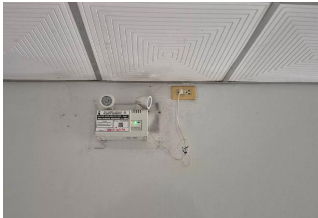
รูปที่ 11 ระบบไฟฟ้าสำรอง
