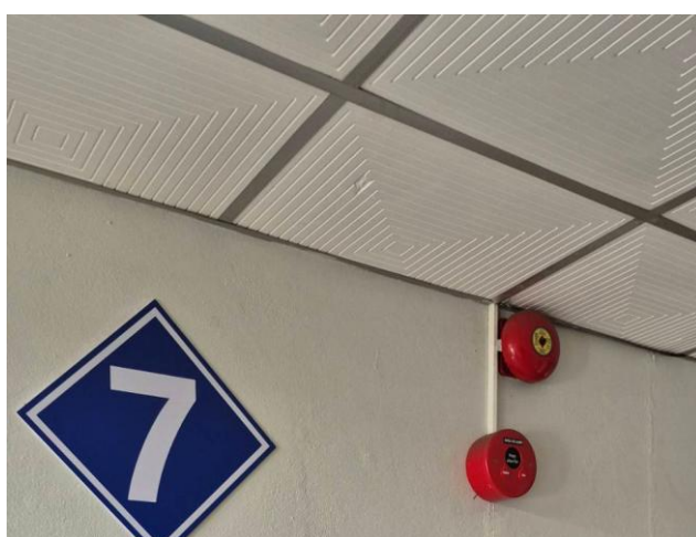
รูปที่ 12 สัญญาณแจ้งเหตุเพลิงไหม้
