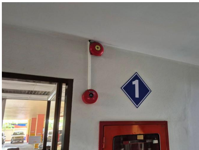
รูปที่ 12 สัญญาณแจ้งเหตุเพลิงไหม้
